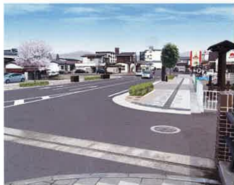
▲施工イメージ
